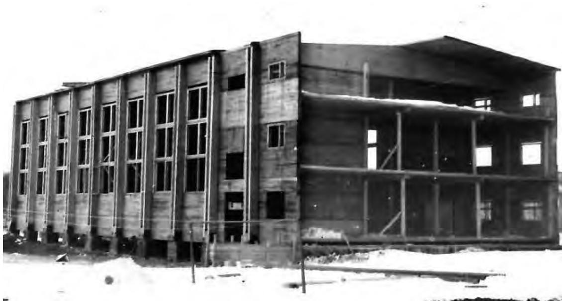
**Рис 1.** Строительство жилого здания из крупноразмерных клееных плит в г. Архангельске, 1985 г.
