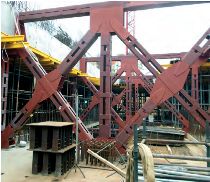
Рис. 7. Система распорных ферм котлована строящейся гостиницы в г. Москве
