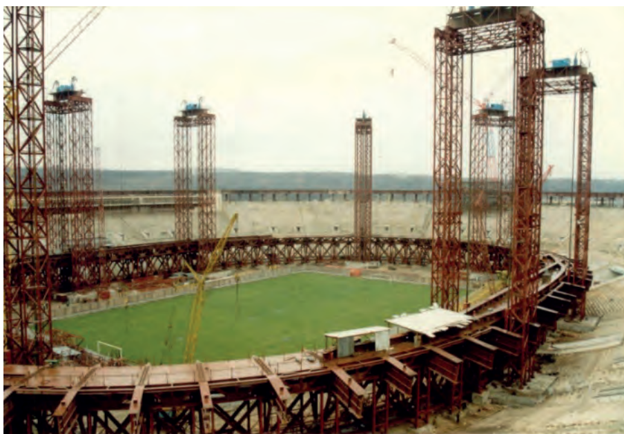
Рис. 1. Монтаж внутреннего контура БСА с установленными в контрольных сечениях механическими тензометрами для взятия начальных отсчетов на элементах конструкций без нагрузки
