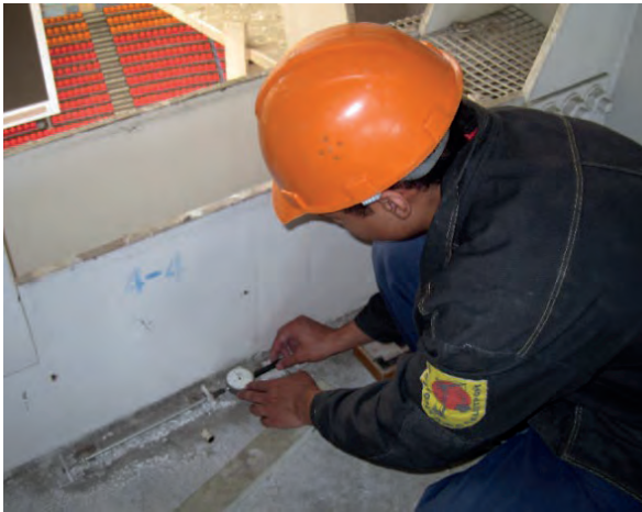
Рис. 6. Установка и снятие показаний с приборов на конструкции покрытия и временных связях при реконструкции БСА
