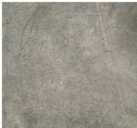
Рис. 1. Фрагмент пола, на поверхности которого видны хаотично расположенные волосяные трещины
