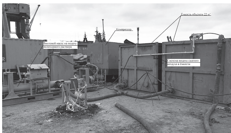
Рис. 7. Общий вид опытной площадки
