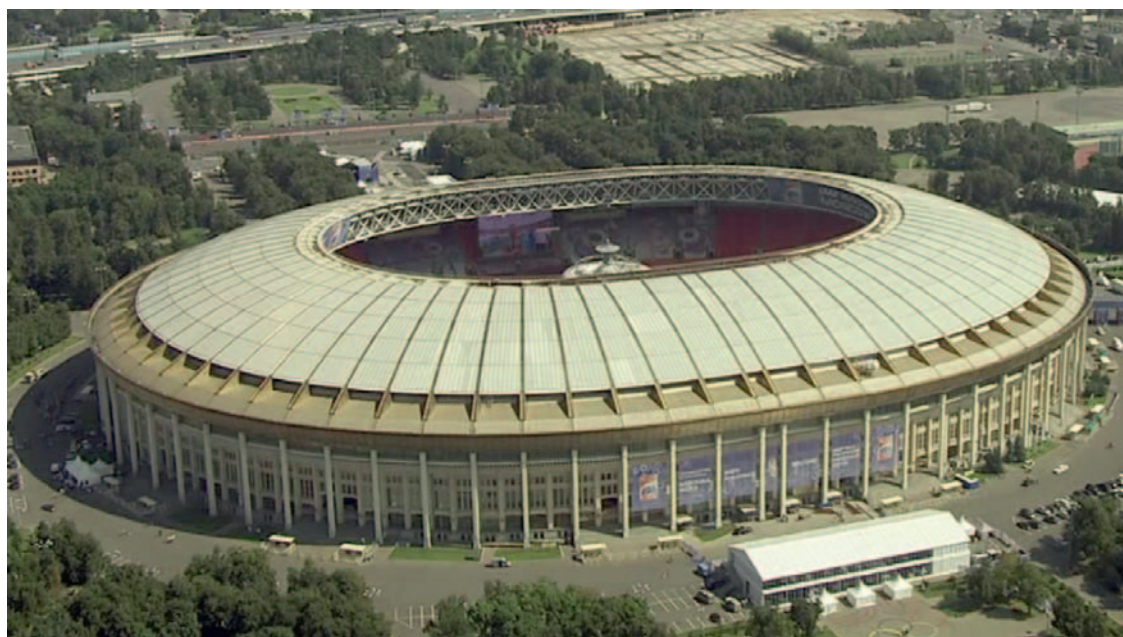
Рис. 1. Общий вид БСА «Лужники» до проведения реконструкции Fig. 1. General view of the Luzhniki GSA prior to reconstruction
