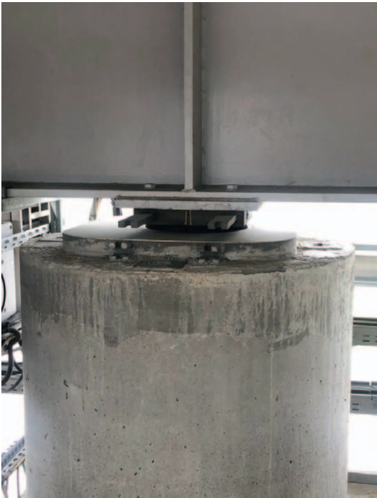
Рис. 5. Шарнирная опора ездовой фермы Fig. 5. Hinge bearing of deck frame
