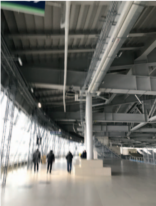
Рис. 6. Стальные колонны, на которые опирается покрытие стадиона Fig. 6. Steel columns bearing stadium shell
