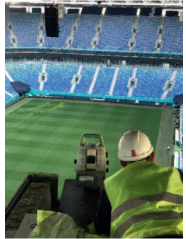
Рис. 19. Процесс монтажа и наладки автоматизированной системы Fig. 19. Installation and commissioning of an automated system
