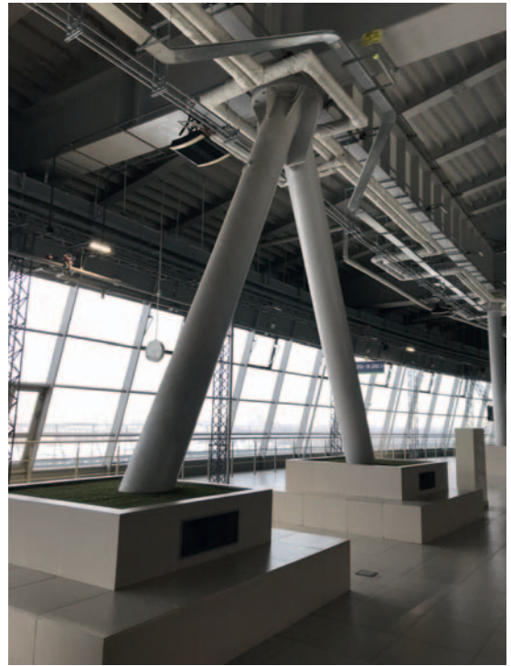
Рис. 7. Л-образные колонны, расположенные в осях симметрии покрытия стадиона
