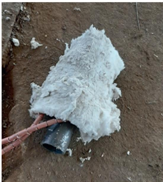
Рис. 1. Дегазация участка старой трубы перед наплавкой
