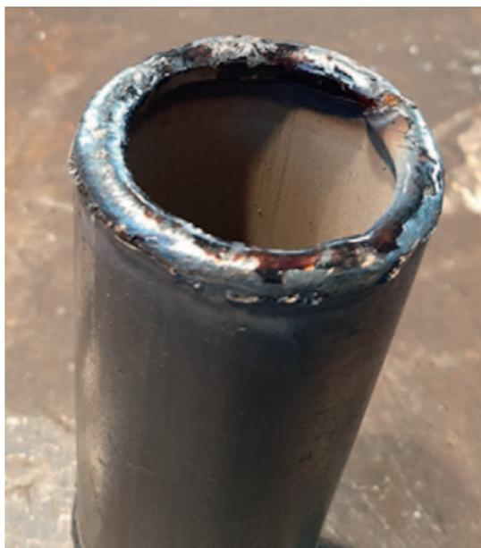
Рис. 2. Предварительная наплавка кромки «старой» трубы
