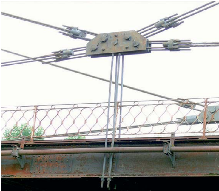
Fig. 18. Characteristic central node for the Gisclard system, element of the cable-stayed suspension bridge “Pont suspendu de Bourret” in France Рис. 18. Характерный центральный узел для системы Жискляра, элемент вантового висячего моста «Pont suspendu de Bourret» во Франции
