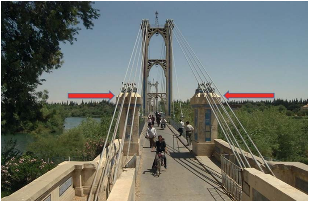
Fig. 9. The extreme anchor pylon of the cable-stayed suspension bridge in Deir ez-Zor (modern view until 2013) Рис. 9. Крайний анкерный пилон вантового висячего моста г. Дейр-эз-Зора (современный вид до 2013 года)
