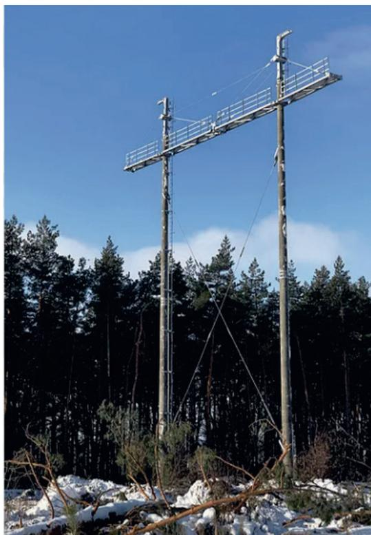
Рис. 1. Опора из центрифугированных секционированных стоек
