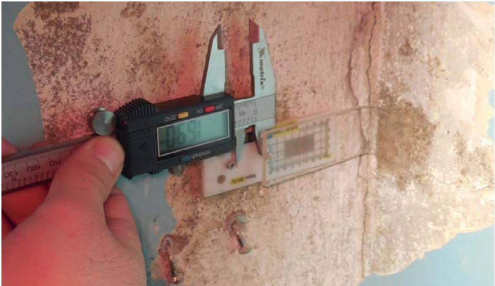
Рис. 11. Контроль показаний деформометров Fig. 11. Readings of strain gauges
