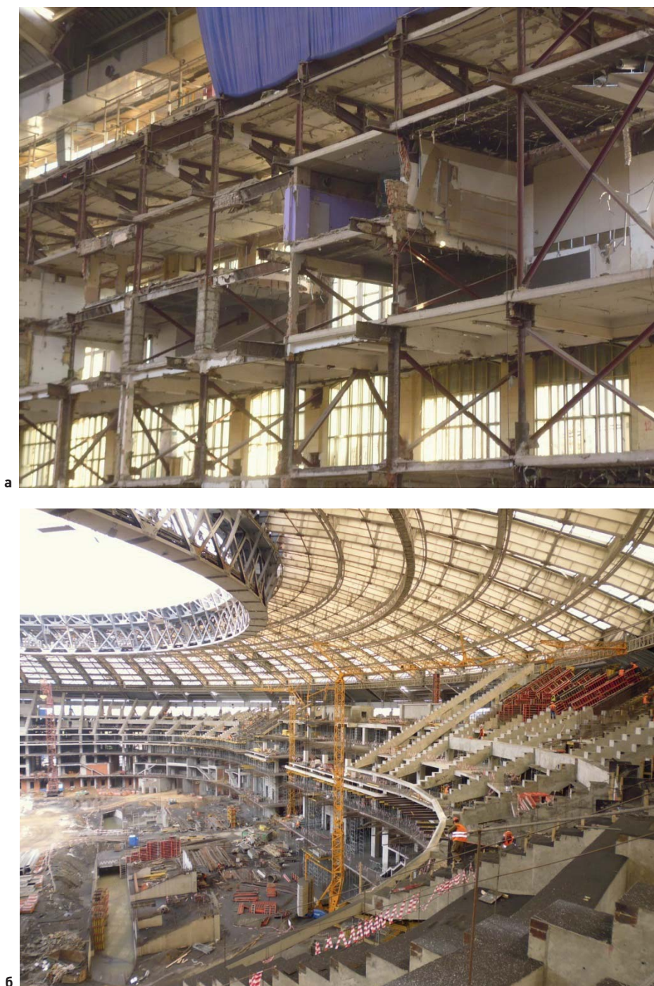
Рис. 8. а – фрагмент системы с усилением «фасадная стена + 1 пролет каркаса трибун, усиленный связями»; б – фрагмент этапа демонтажа трибун Fig. 8. а – fragment of the system with reinforcement “front wall + 1 span of the stand framework reinforced with braces”; б – fragment at the stand dismantling stage
