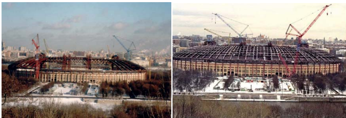
Рис. 15. Вид на покрытие БСА во время монтажа Fig. 15. View of the GSA roof during installation
