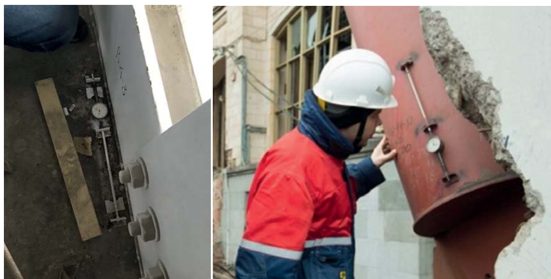
Рис. 28. Измерение напряжений при проведении реконструкции стадиона «Лужники» Fig. 28. Stress measurements during the reconstruction of the Luzhniki Stadium
