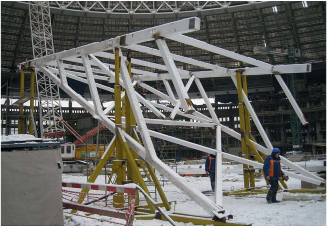
Рис. 26. Консольный элемент, увеличивающий площадь покрытия БСА, в кондукторе Fig. 26. Cantilever element increasing the coverage area of the GSA in the jig
