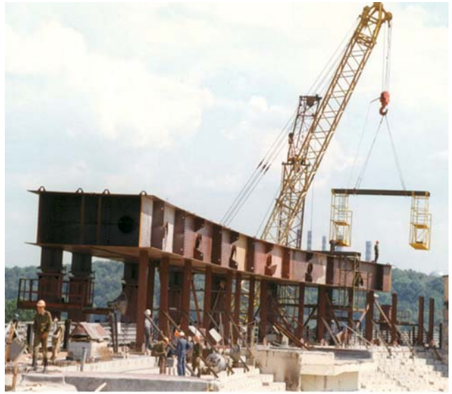
Рис. 9. Установка наружного контура на колонны: а – колонны покрытия БСА; б – наружный опорный контур покрытия БСА
