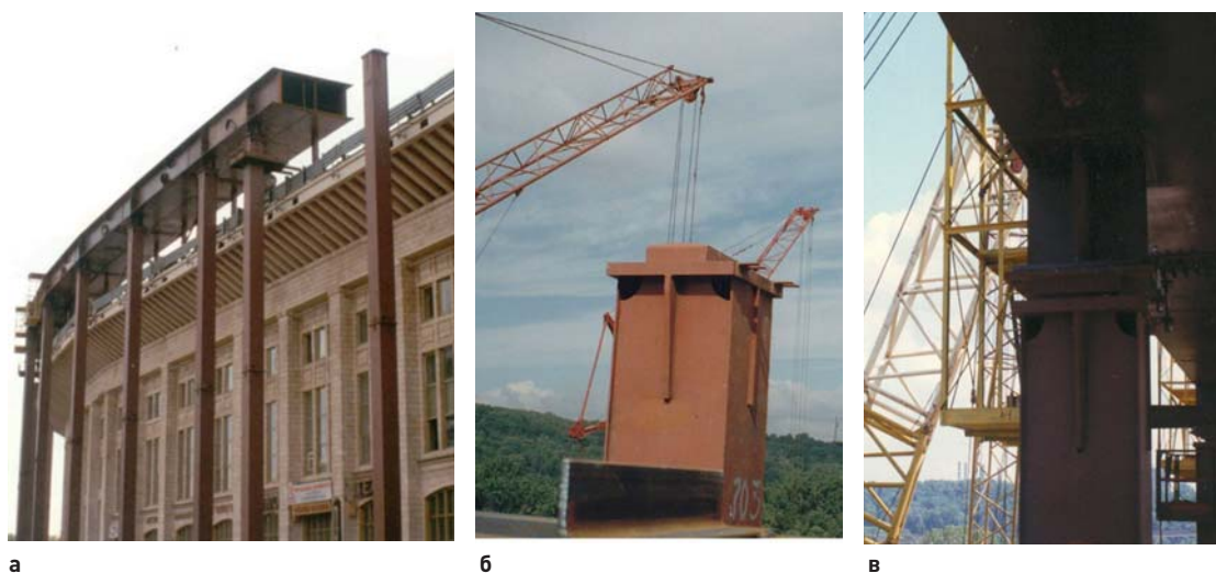
Рис. 8. Монтаж наружного опорного контура: а – установка наружного опорного контура на колонны; б – верхняя часть колонны; в – узел сопряжения колонны с наружным контуром Fig. 8. Installation of the outer support contour: а – installation of the outer support contour on the columns; б – the upper part of the column; в – column to outer contour joint
