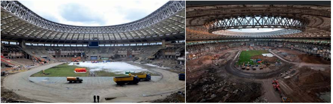
Рис. 21. Демонтаж трибун стадиона «Лужники» Fig. 21. Dismantling of the Luzhnik Stadium stands
