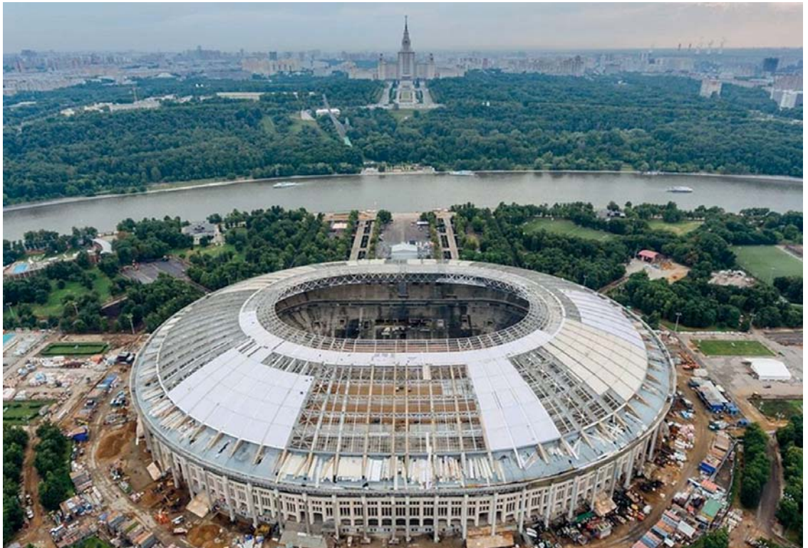
Рис. 31. Установка новых светопрозрачных панелей из поликарбоната Fig. 31. Installation of new translucent polycarbonate panels
