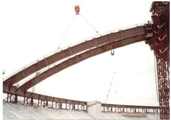
Рис. 14. Монтаж криволинейных радиальных балок Fig. 14. Installation of curved radial beams
