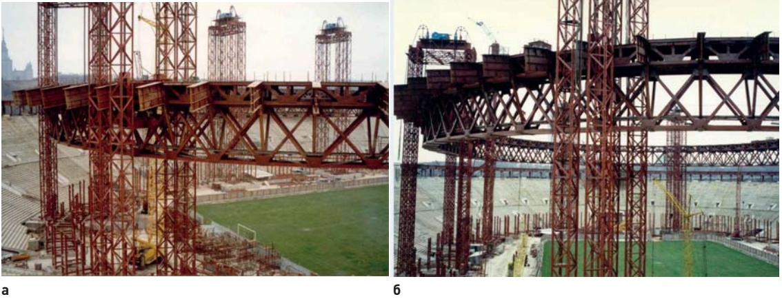
Рис. 13. Подъем внутреннего контура на проектную отметку Fig. 13. Lifting the inner contour to the design level
