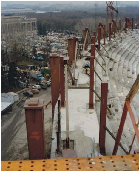
Рис. 9. Установка наружного контура на колонны: а – колонны покрытия БСА; б – наружный опорный контур покрытия БСА
