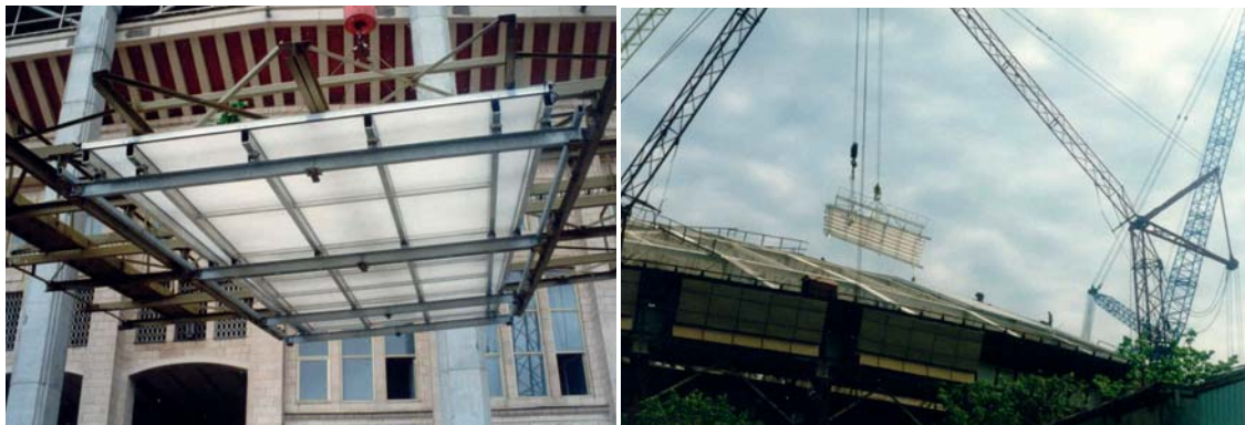
Рис. 16. Монтаж светопрозрачной кровли: а – подъем светопрозрачной панели; б – монтаж панели на покрытие БСА
