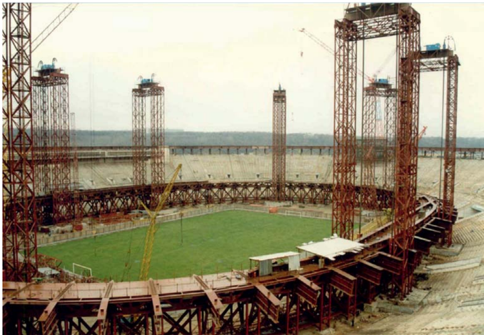
Рис. 12. Внутренний контур собран Fig. 12. Inner contour assembled
