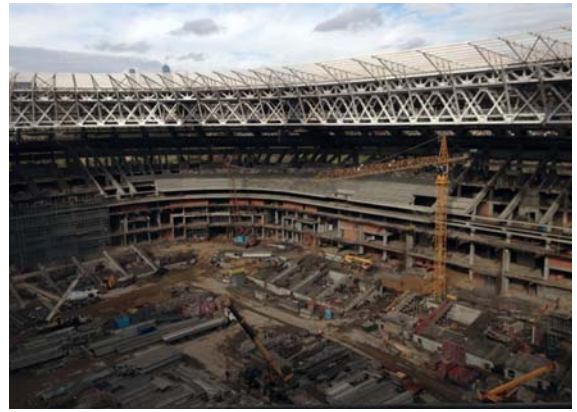
Рис. 27. Монтаж консольной части покрытия БСА Fig. 27. Installation of the cantilever part of the GSA roof
