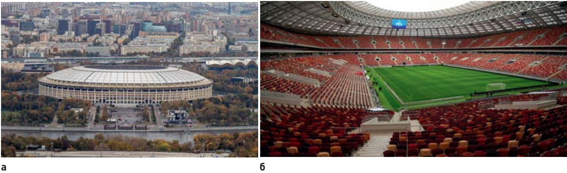
Рис. 32. Фасад (а) и интерьер (б) реконструированного стадиона, который удовлетворяет требованиям FIFA для стадионов, на которых проводятся матчи открытия и финала Кубка мира по футболу Fig. 32. Facade (a) and interior (b) of the reconstructed stadium, which meets FIFA requirements for the stadiums hosting the opening and final matches of the FIFA World Cup
