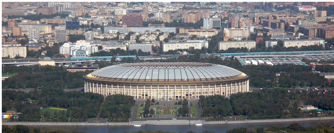
Рис. 17. Фасад стадиона после возведения покрытия Fig. 17. The stadium facade after the erection of the roof
