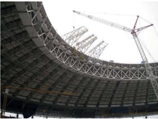
Рис. 27. Монтаж консольной части покрытия БСА Fig. 27. Installation of the cantilever part of the GSA roof
