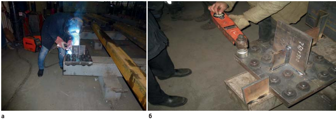
Рис. 24. Испытания влияния температуры на несущую способность высокопрочных болтов: а – сварка модели элемента, позволяющего увеличить площадь покрытия БСА; б – проверка натяжения высокопрочных болтов Fig. 24. Testing the effect of temperature on the load-bearing capacity of high-strength bolts: а – welding of the model of the element to increase the coverage area of the GSA; б – testing of the tension of high-strength bolts
