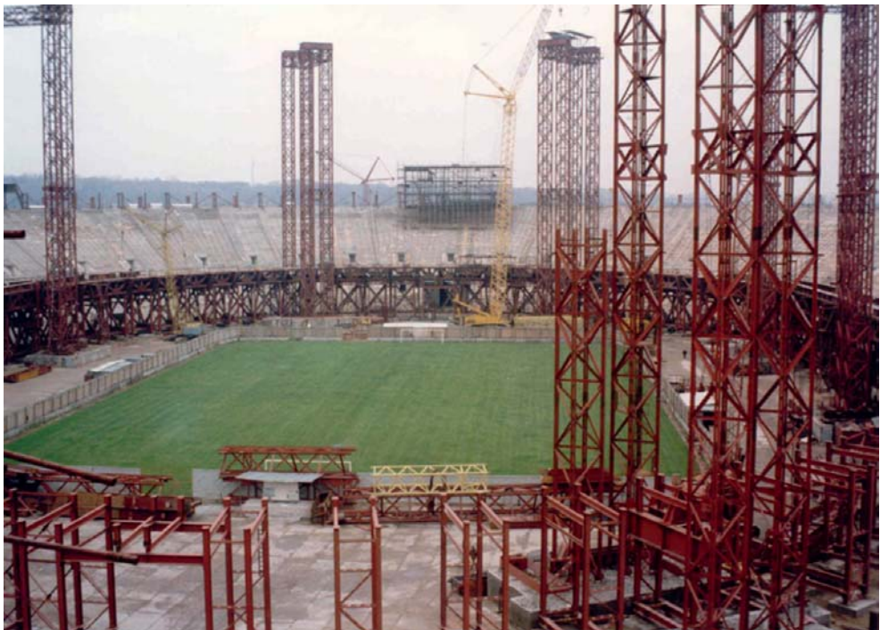
Рис. 11. Сборка внутреннего контура на подмостях Fig. 11. Assembling the inner contour on scaffolds
