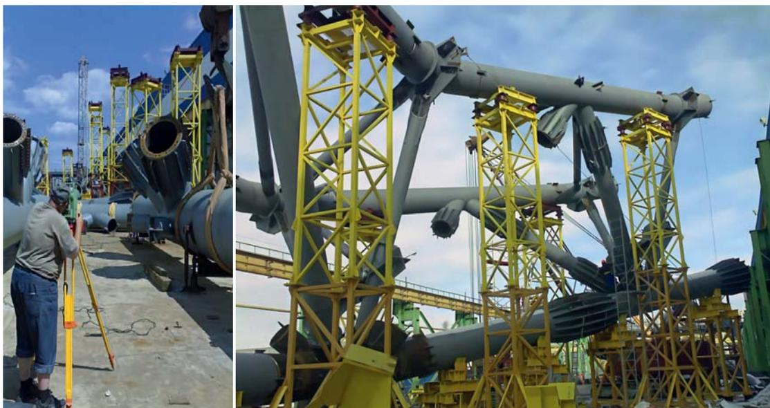
**Рис. 13.** Трехмерная сборка секций главного ригеля из изготовленных элементов на строительной площадке в г. Казани
