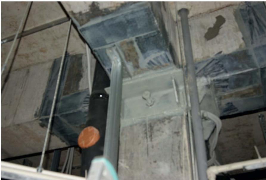
**Рис. 10.** Усиление рамного узла
