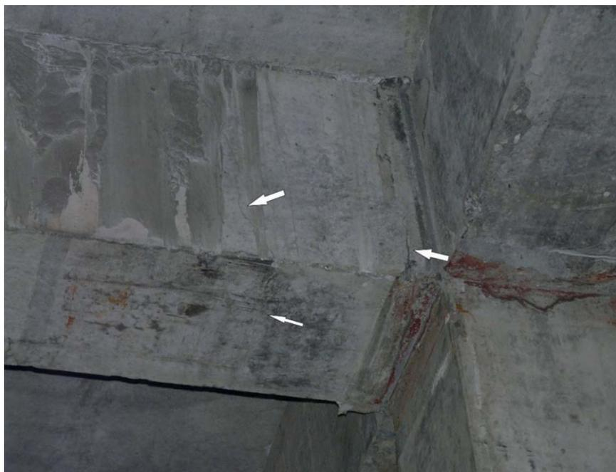
**Рис. 8.** Вертикальная трещина шириной раскрытия 5 мм; наклонная трещина шириной раскрытия 2 мм; сеть трещин по нижней грани опорного паза шириной раскрытия 1–2 мм
