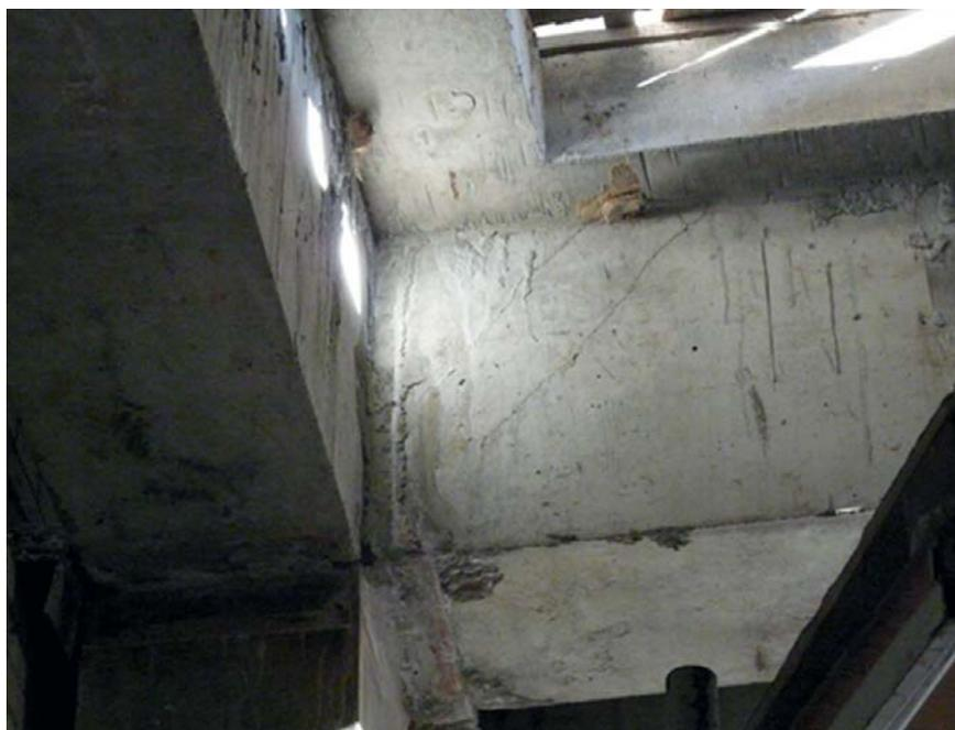
**Рис. 9.** Наклонные трещины в зоне сопряжения с колонной шириной раскрытия до 2 мм
