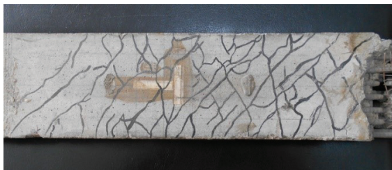
Рис. 1. Опытный образец ТАЦ со следами трещин
