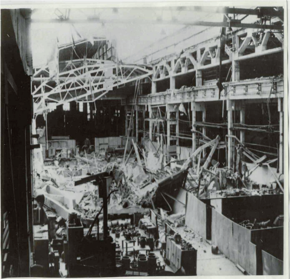
Рис.1. Разрушение заводского цеха в результате карстового провала в Дзержинске
