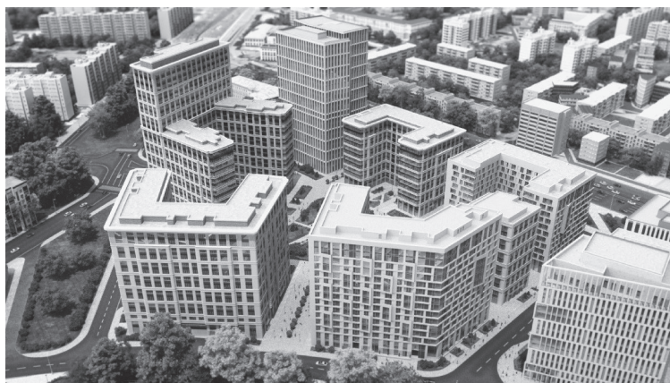
Рис. 1. Общий вид фасадов зданий с «узкими» простенками
