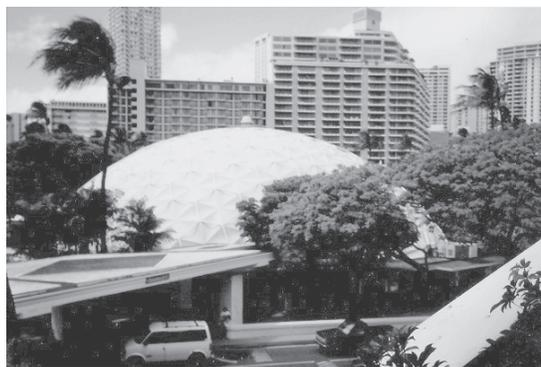
Рис. 4. Геодезический купол системы Фуллера в Гонолулу
