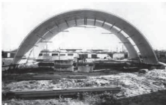
**Рис. 7.** Однослойные фрагменты покрытия во время испытания
