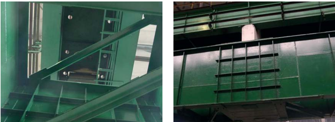
Рис. 5. Опираение на портал верхней части вырубленной колонны Б37 Fig. 5. Upper part of the demolished B37 column, supported by the portal
