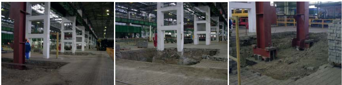
Рис. 7. Устройство фундаментов колонны В27 Fig. 7. B27 column foundation
