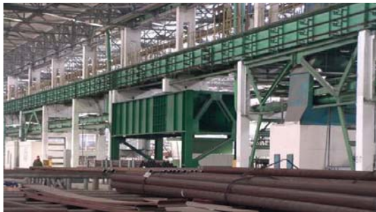
Рис. 3. Порталы в здании ТСЦ-4 по ряду В (вид из пролета Б-В) в местах выбитых колонн: а – В21; б – В37 Fig. 3. Portals in the TSCs-4 building along the row В (view from the В-В span) in locations of demolished columns: а – В21; б – В37
