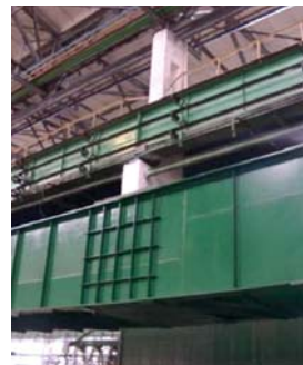
Рис. 4. Опираение на портал верхних частей вырубленной колонны В21 и передача нагрузки с покрытия здания ТСЦ-4 через верхнюю часть колонны В21 на балку портала (вид со стороны ряда В) Fig. 4. Upper parts of the demolished В21column, supported by the portal and the load, transferred from the TSCs-4 building roof through the upper part of the В21 column to the portal beam (view from the В row)
