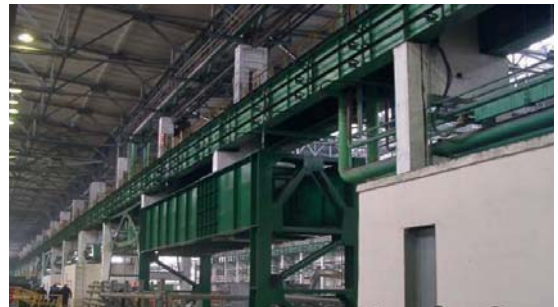
Рис. 3. Порталы в здании ТСЦ-4 по ряду В (вид из пролета Б-В) в местах выбитых колонн: а – В21; б – В37 Fig. 3. Portals in the TSCs-4 building along the row В (view from the В-В span) in locations of demolished columns: а – В21; б – В37
