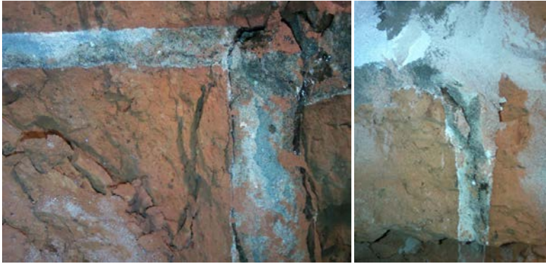
Рис. 5. Вскрытие кладки из исторического кирпича с целью определения границ зоны пропитки метилметакрилатом
