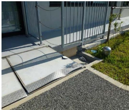
Рис. 10. Поврежденный элемент ограждения антисейсмического шва [13]
