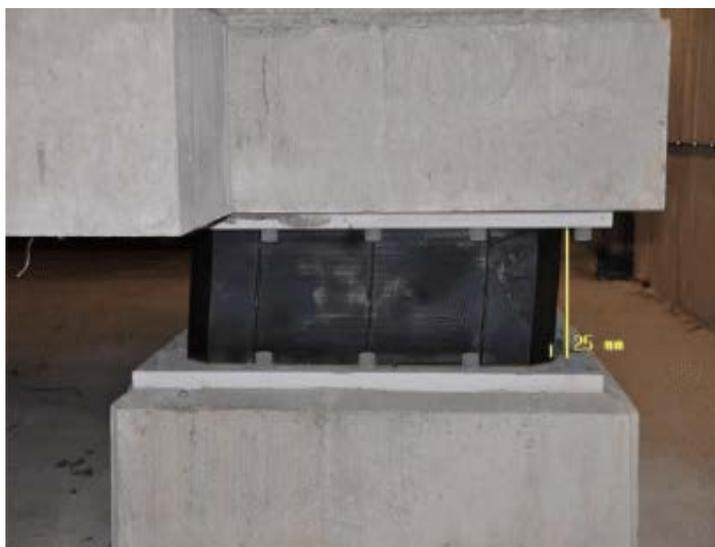
**Рис. 6.** Остаточное смещение резинометаллической сейсмоизолирующей опоры в осях «F»–«З» [6]
