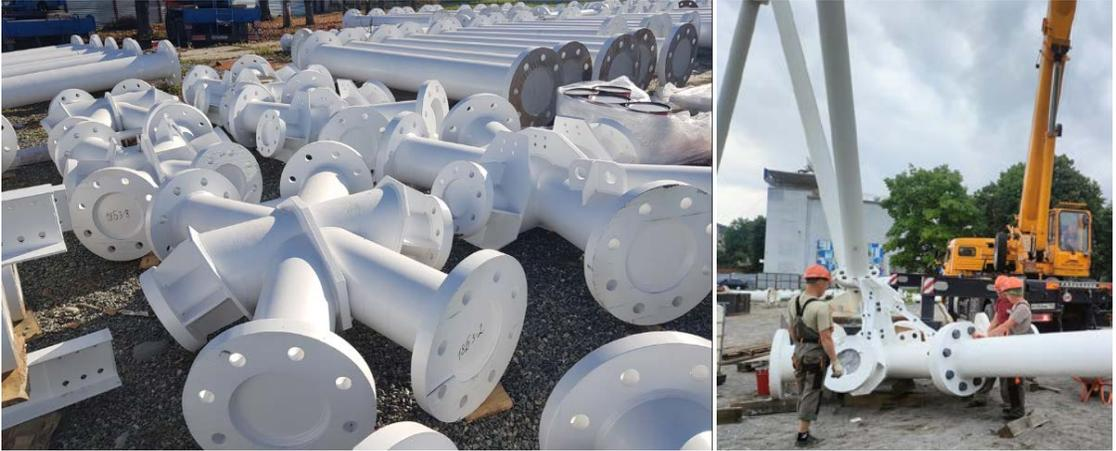
**Рис. 5.** Готовые к монтажу узлы и элементы и начало сборки конструкции башни
