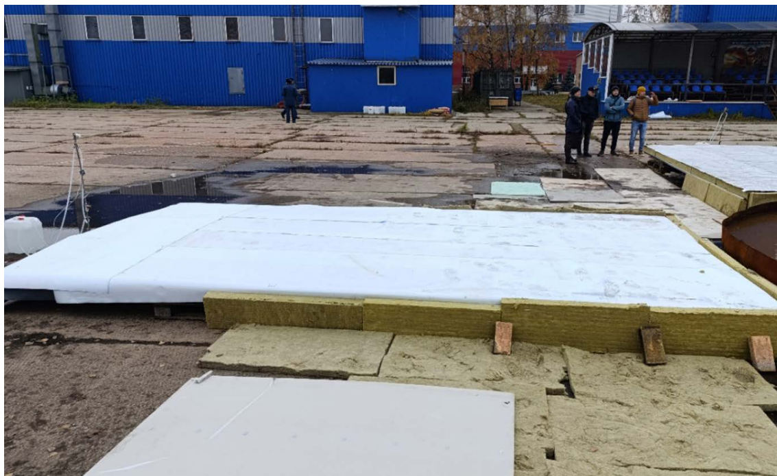
Рис. 4. Образец 4 перед началом испытаний Fig. 4. Sample 4 before testing
