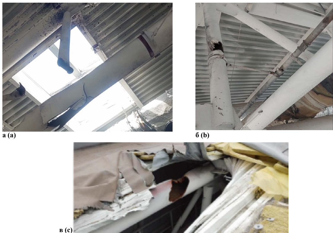
Рис. 2. Повреждения арок с затяжкой сквозного сечения конструкций покрытия СК «Ильичевец»: а – разрушение нижнего пояса арки сквозного сечения по оси 24; б – повреждение стойки арки сквозного сечения по оси 24; в – повреждение верхнего пояса арки
