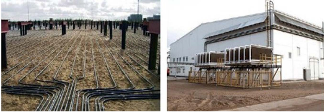
Рис. 3. Система ГЕТ на Ванкорском нефтегазовом месторождении (фото С.Н. Окунева)
