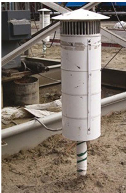
Рис. 6. Противоточный термосифон с электрической насадкой на конденсаторе (фото М.А. Минкина)
