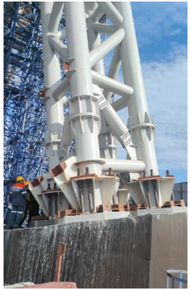
Рис. 8. Установка тензометров на отм. +1,700 (на высоте 1,7 м от отм. \pm 0,000 ) в сечениях 1/А и 1/Г
