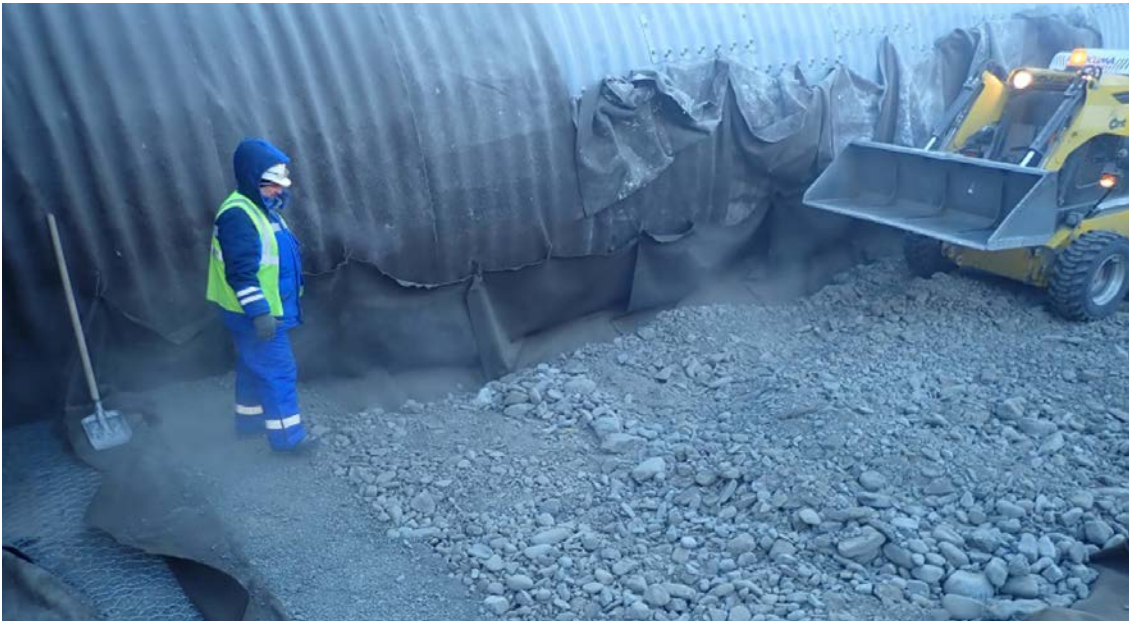
Рис. 2. Гофрированная труба Ø 4,5 м до засыпки Fig. 2. Corrugated pipe Ø 4.5 m before backfilling
