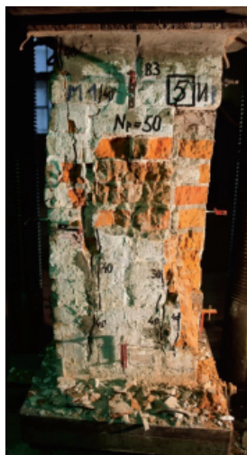
Рис. 11. Образец серии Забут-ЦС-И после второго этапа испытаний Fig. 11. Zabut-CS-I series specimen after the second stage of testing
