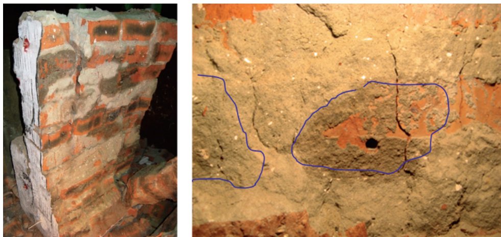
Рис. 6. Вскрытие кладки из современного кирпича с целью определения границ зоны пропитки метилметакрилатом
