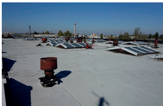
Рис.4. Покрытие плоской кровли пенобетоном
