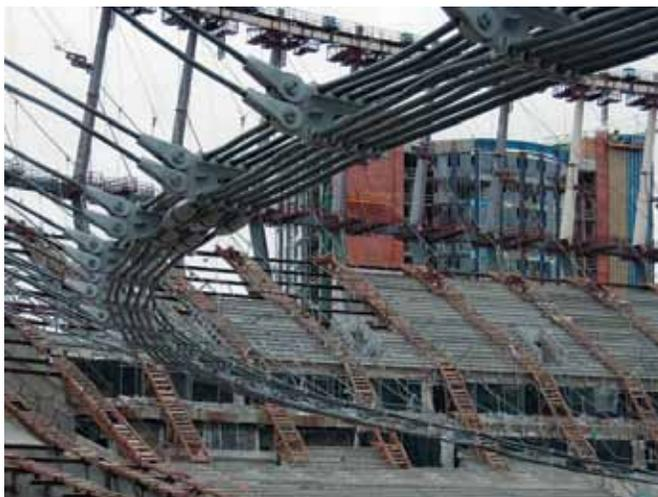
**Рис.12.** Подъем вантового покрытия типа «велосипедное колесо»
