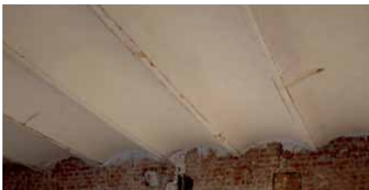
Рис.1. Общий вид арочного перекрытия (своды «Монье»)
