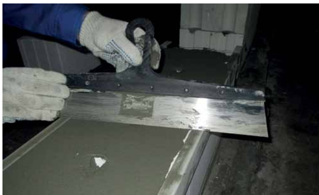
Рис.2. Ведение кладки образцов из силикатных пазогребневых блоков на тонких швах 3–4 мм из клеевого раствора (необходимая толщина шва получается благодаря использованию специально изготовленного кондуктора)
