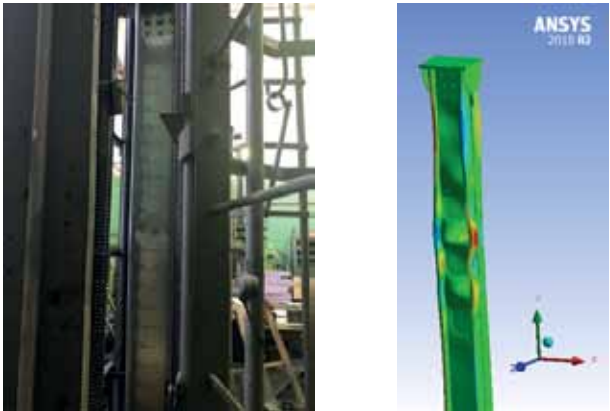
Рис.10. Форма разрушения составной стойки из профилей 2xAC250x110x24x2,5 (потеря местной устойчивости профиля в средней части стойки)
