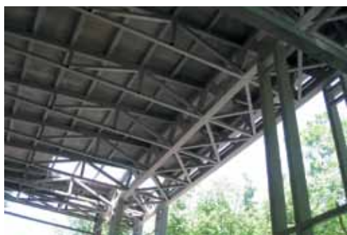
Рис.12. Опираение стропильных на подстропильные фермы по рядам Б и А
