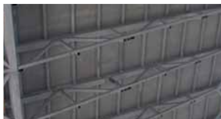
Рис.13. Стропильные фермы покрытия павильонов
