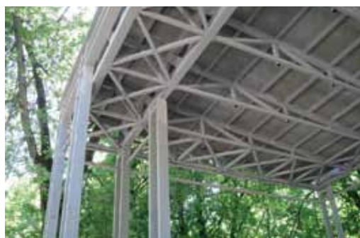
Рис.12. Опираение стропильных на подстропильные фермы по рядам Б и А
