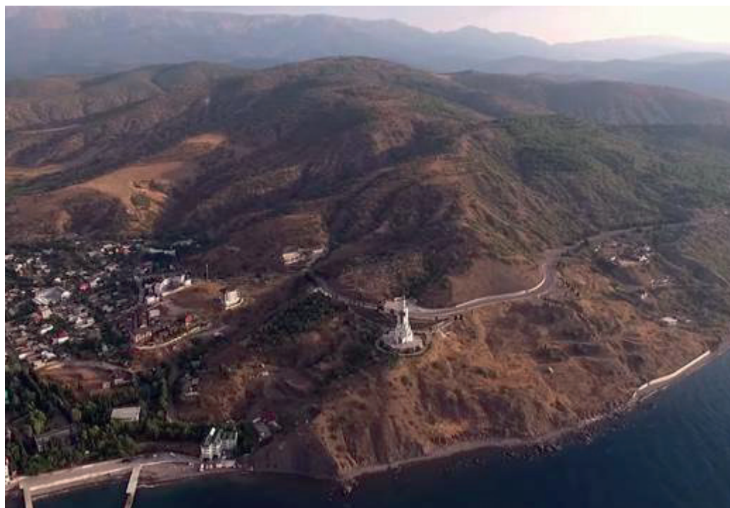
Рис. 1. Общий вид участка строительства берегоукрепительных и противооползневых сооружений
