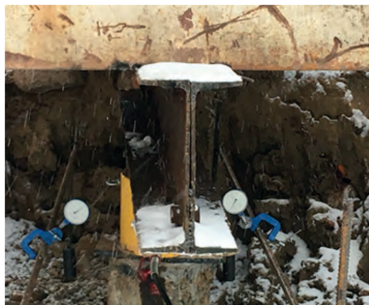
Рис. 2. Фрагмент испытательного стенда на площадке строительства в ЮАО г. Москвы
