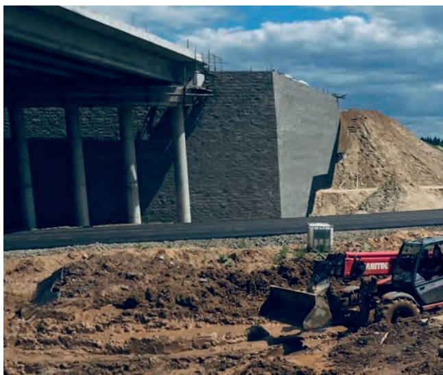
Рис. 9. Реализованный вариант армированной подпорной стенки
