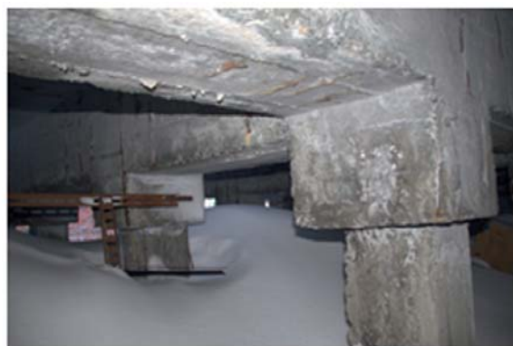
Рис. 1. Скопление снега во дворе (слева) и в вентилируемом подполье (справа) жилого здания в г. Норильске Fig. 1. Snow accumulation in the yard (left) and in the ventilated underfloor space (right) of a residential building in the city of Norilsk
