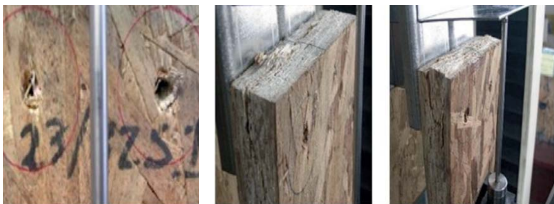
а Рис. 8. Наблюдаемые виды отказов [42]: а – сквозные панели обшивки саморезов через зону соединения элементов; б – растрескивание панели обшивки по толщине Fig. 8. Observed failure modes [42]: a – protruding self-tapping screw through element joint area; b – cladding panel cracking over thickness
