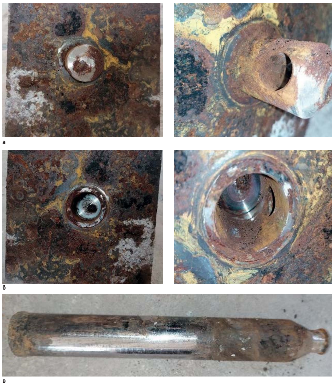
Рис. 6. Общий вид и характерные повреждения элементов штифтового соединения (в разобранном виде) образцов серии № 1 (без коррозионной защиты) после ускоренных коррозионных испытаний при режиме № 2 в течение 90 суток: а – торцевая пластина с фиксирующим штырем; б – торцевая пластина с фиксирующим пазом; в – забивной штифт
