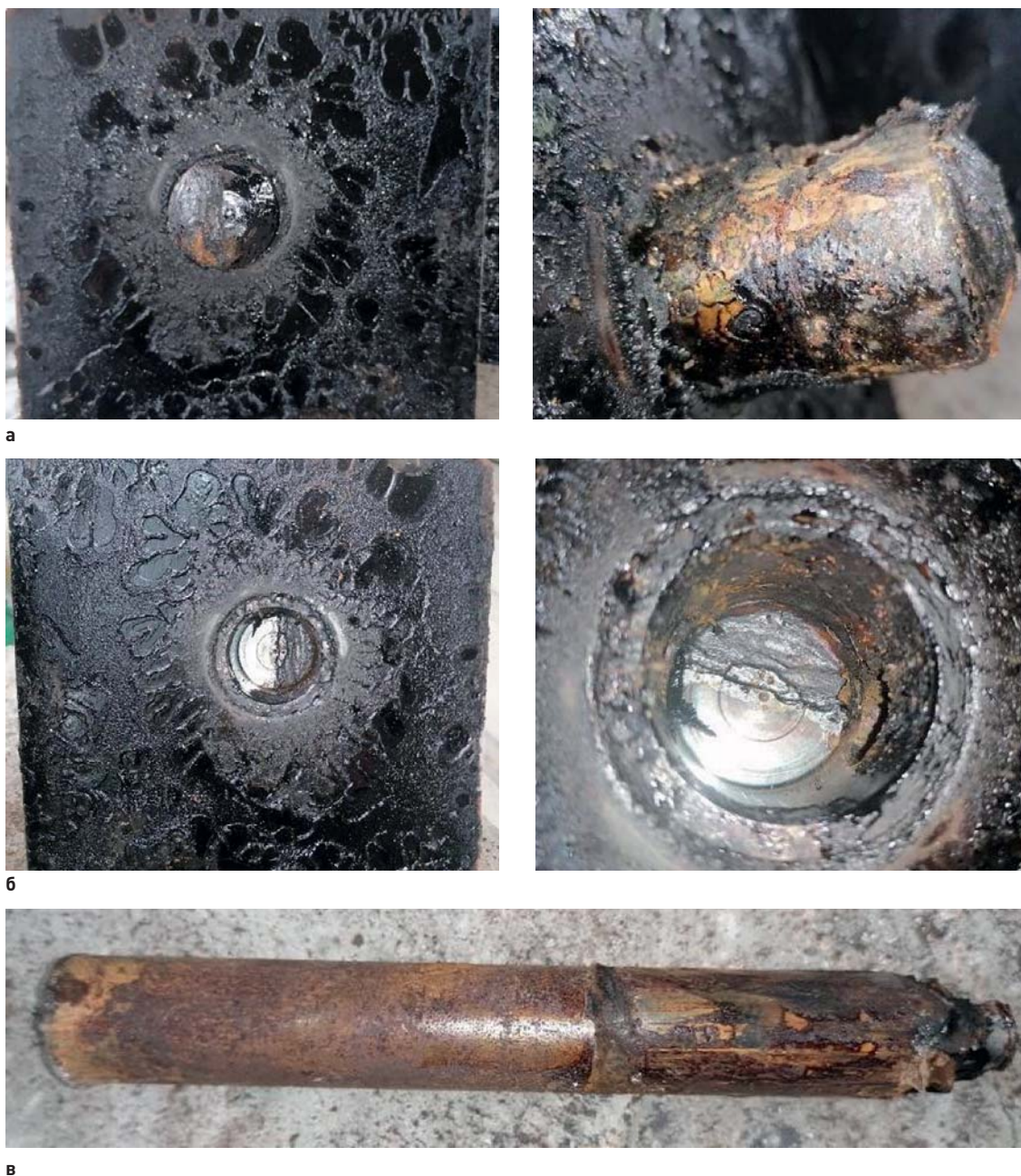
Рис. 8. Общий вид и характерные повреждения элементов штифтового соединения (в разобранном виде) образцов серии № 3 после ускоренных коррозионных испытаний при режиме № 2 в течение 90 суток: а – торцевая пластина с фиксирующим штырем; б – торцевая пластина с фиксирующим пазом; в – забивной штифт
