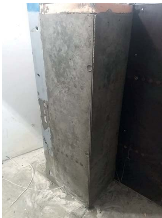
Рис. 2. Общий вид колонны без экструзионного пенополистирола ПЕНОПЛЭКС на этапе 1 Fig. 2. General view of the column without the PENOPLEX extruded polystyrene foam in the stage 1
