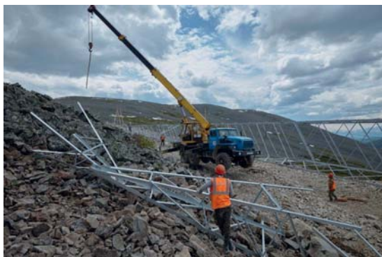
Рис. 1. Процесс монтажа опор ВЛ для ГМК «Удоканская медь» на склоне с курумом (фото с сайта Чита.ру) Fig. 1. Installation of overhead line towers for Udokan Copper on a slope having a stone run (photo from https://www.chita.ru/ )
