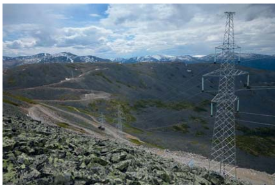
Рис. 1. Процесс монтажа опор ВЛ для ГМК «Удоканская медь» на склоне с курумом (фото с сайта Чита.ру) Fig. 1. Installation of overhead line towers for Udokan Copper on a slope having a stone run (photo from https://www.chita.ru/ )
