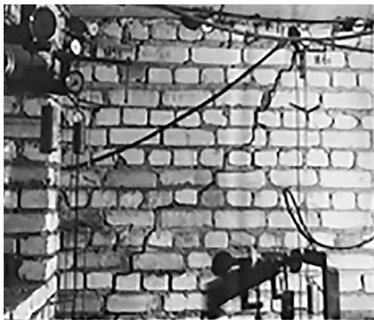
**Рис. 5.** Трещина по шву между плитами перекрытия, переходящая в наклонную трещину в кладке внутренней стены
