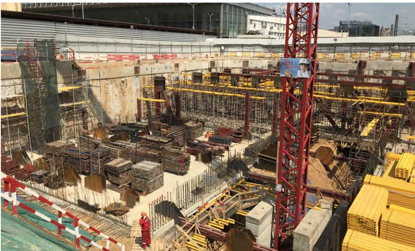
**Рис. 2.** «Стена в грунте» и распорные фермы первого подземного яруса
