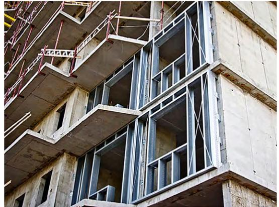
**Рис. 4.** Применение каркасов из ЛСТК в ограждающих конструкциях зданий
