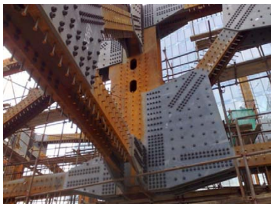
Рис. 3. Сталебетонные конструкции аутригеров технических этажей МК Федерация из самоуплотняющегося бетона класса В90: а – стальные конструкции аутригеров; б – поверхность забетонированной конструкции
