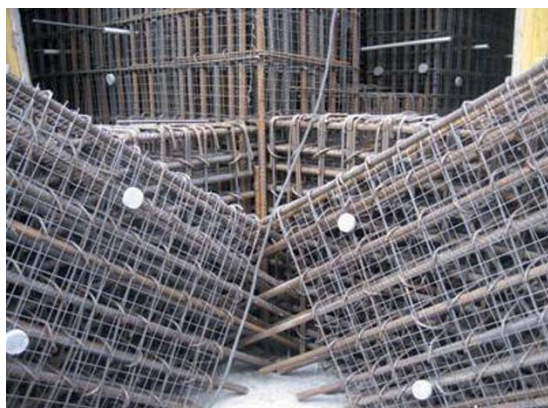
Рис. 2. Густоармированные железобетонные конструкции аутригеров технических этажей МК Город столиц из самоуплотняющегося бетона класса В60:
