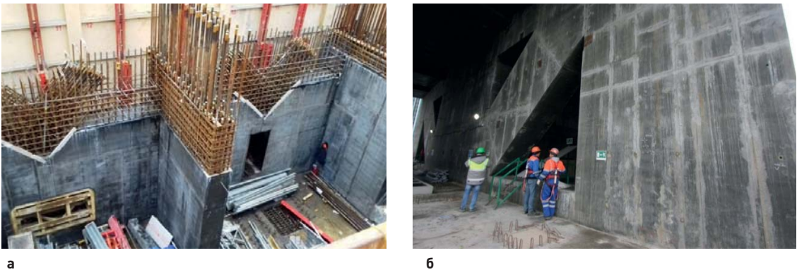
а б расход арматуры класса А600 С диаметром 12–40 мм от 342 до 680 кг/м 3 Рис. 4. Густоармированные железобетонные конструкции аутригеров технических этажей МК Нева из самоуплотняющегося бетона класса В100
