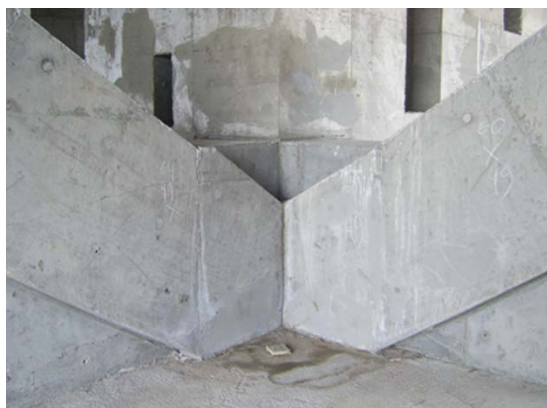
Рис. 2. Густоармированные железобетонные конструкции аутригеров технических этажей МК Город столиц из самоуплотняющегося бетона класса В60:
