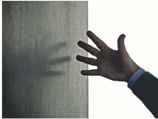
Рис. 3. Сталебетонные конструкции аутригеров технических этажей МК Федерация из самоуплотняющегося бетона класса В90: а – стальные конструкции аутригеров; б – поверхность забетонированной конструкции
