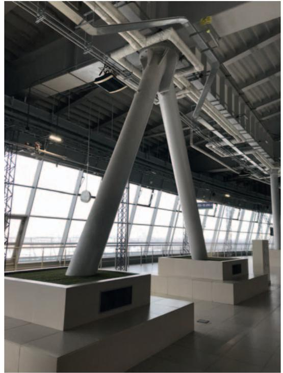
Рис. 7. Л-образные колонны, расположенные в осях симметрии покрытия стадиона
