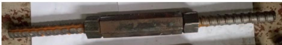
**Рис. 3.** Винтовое механическое соединение
