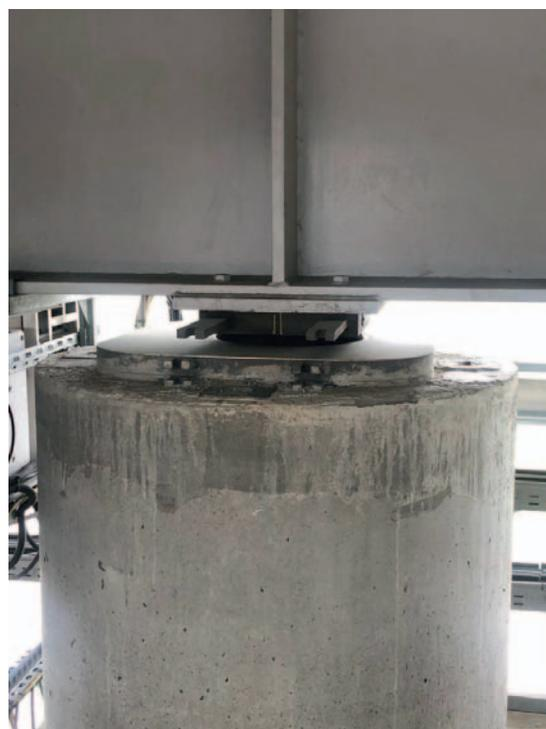
**Рис. 5.** Шарнирная опора ездвой фермы
