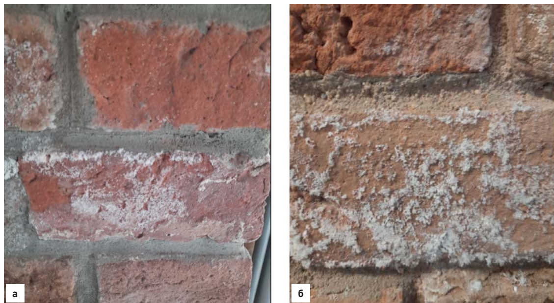
Рис. 4. Место отбора проб налета: а – проба № 1; б – проба № 2 Fig. 4. Plaque sampling points: а – sample No. 1; б – sample No. 2
