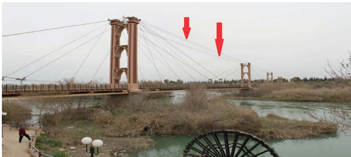
Fig. 22. Historic cable-stayed suspension bridge of Deir ez-Zor, Syria. The arrows show the stiffening cables Рис. 22. Исторический вантовый висячий мост города Дейр-эз-Зора, Сирия. Стрелками показаны кабели жесткости
