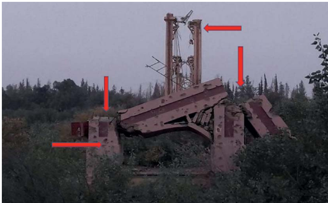
Fig. 10. Damaged and destroyed pylons of the cable-stayed suspension bridge in Deir ez-Zor. The arrows show damage Рис. 10. Поврежденные и разрушенные пилоны вантового висячего моста г. Дейр-эз-Зора. Стрелками показаны повреждения
