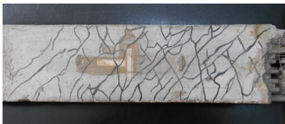
Рис. 1. Опытный образец ТАЦ со следами трещин
