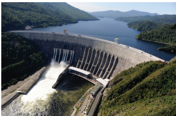
Рис. 4. Саяно-Шушенская ГЭС (обследование конструкций машинного зала после аварии гидроагрегата)
