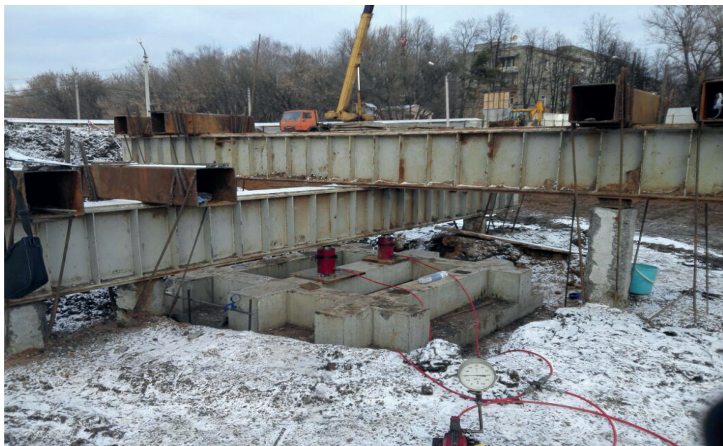
Рис. 8. Общий вид испытательного стенда
