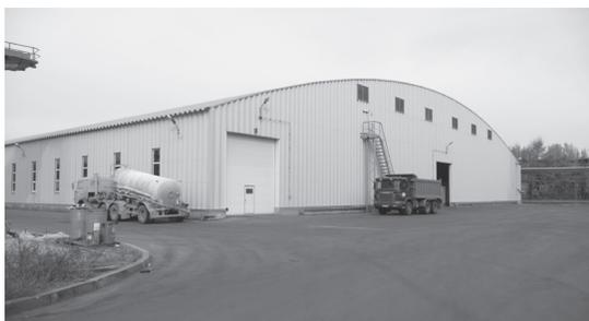
**Рис. 11.** Бескаркасное здание типа Нонсо
