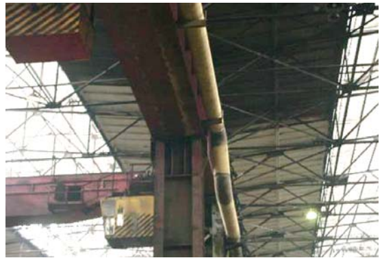
Рис. 16. Стропильные фермы и связи покрытия здания ТПЦ-2 над колонной портала Д18'
