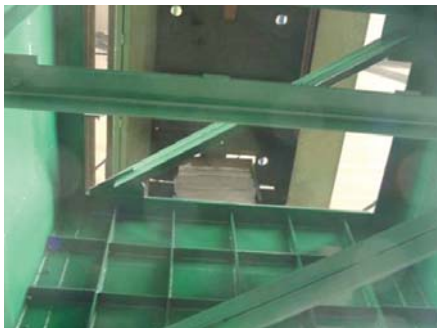
Рис. 4. Опираение на портал верхних частей вырубленной колонны В21 и передача нагрузки с покрытия здания ТСЦ-4 через верхнюю часть колонны В21 на балку портала (вид со стороны ряда В) Fig. 4. Upper parts of the demolished В21column, supported by the portal and the load, transferred from the TSCs-4 building roof through the upper part of the В21 column to the portal beam (view from the В row)
