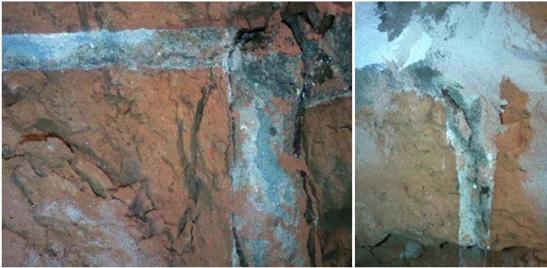
**Рис. 5.** Вскрытие кладки из исторического кирпича с целью определения границ зоны пропитки метилметакрилатом
