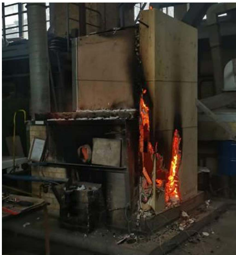
Рис. 13. Фрагмент конструкции стены с двумя слоями ГКЛ во время испытаний Fig. 13. Fragment of a wall structure with two plasterboard sheets during testing
