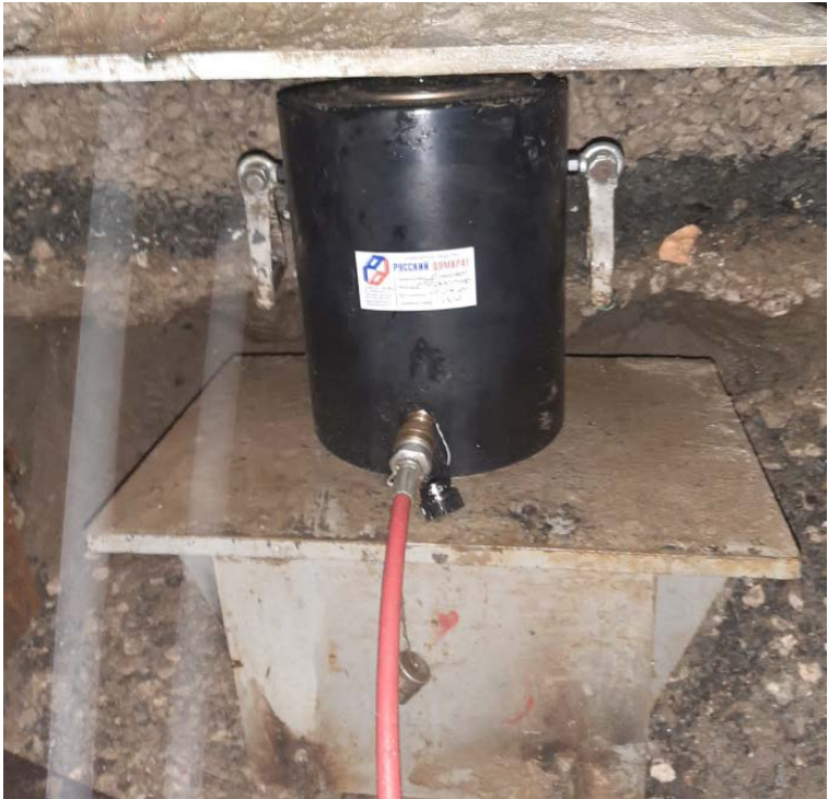
Рис. 8. Испытания свай (применяется домкрат грузоподъемностью 200 т) Fig. 8. Pile load testing using a 200 ton capacity jack
