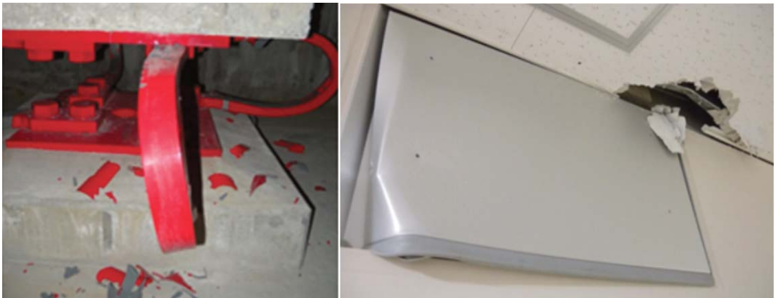
Рис. 8. Примеры обнаруженных повреждений: а – остаточная деформация U-образного стального демпфера; б – повреждение защитной ограждающей панели антисейсмического шва [12]
