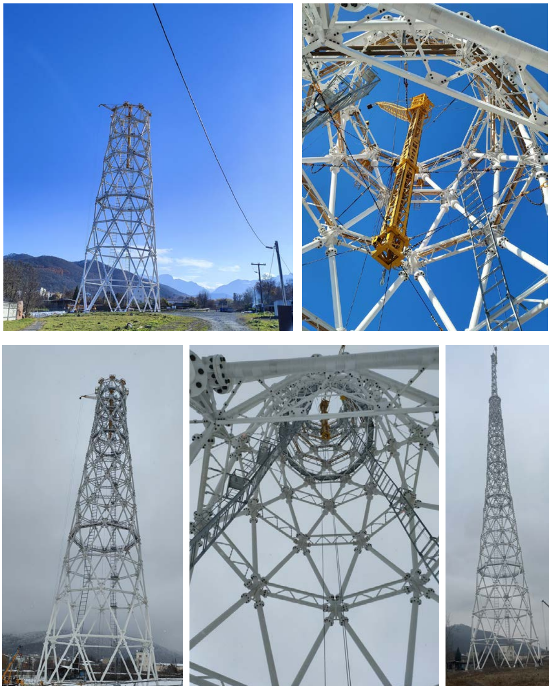
Рис. 6. Процесс монтажа уникальной башни радиотелевизионной передающей станции в г. Владикавказе Fig. 6. Installation of a unique radio and television transmitting tower in Vladikavkaz
