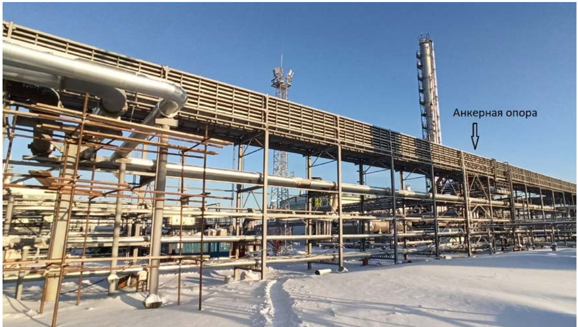
Рис. 3. Часто встречаемая компоновка температурного блока технологической эстакады. Анкерная опора в середине температурного блока, промежуточные опоры выполнены с шарнирным опиранием на фундаменты, все опоры соединены распорками и пролетными строениями (фото из личного архива авторов)
