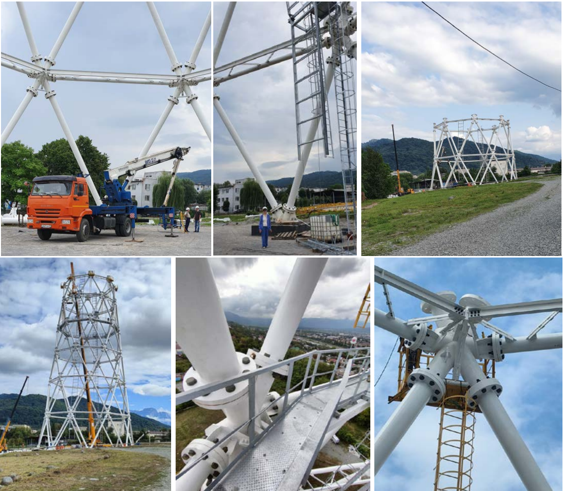
Рис. 5. Готовые к монтажу узлы и элементы и начало сборки конструкции башни Fig. 5. Ready-to-install units and components and start of tower assembly
