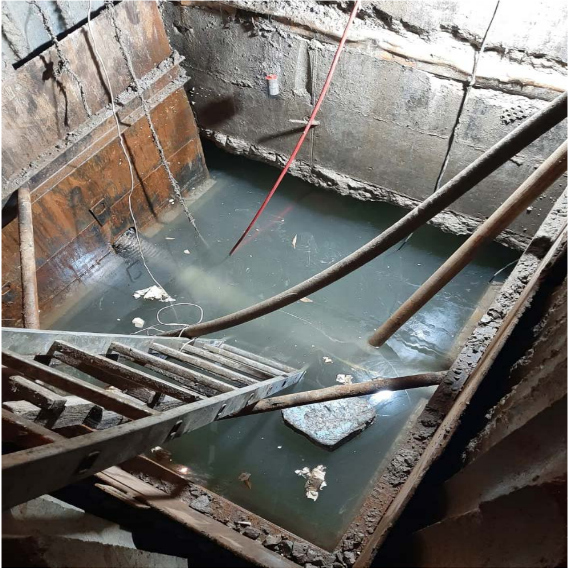
Рис. 6. Шурф для испытания грунтов сваями Fig. 6. Test pit for pile load testing of soils
