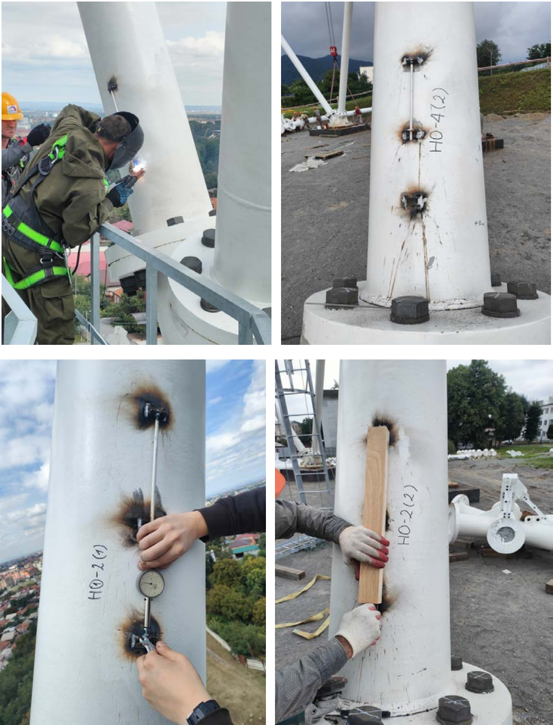
Рис. 9. Приварка элементов базы тензометра к конструкции башни и его настройка. Установка защитного устройства на тензомер
