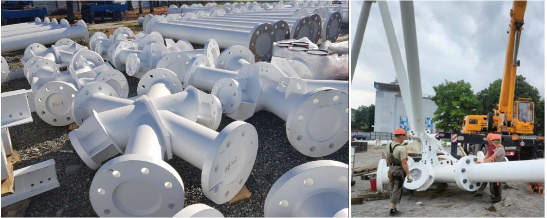
Рис. 5. Готовые к монтажу узлы и элементы и начало сборки конструкции башни Fig. 5. Ready-to-install units and components and start of tower assembly
