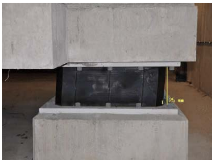
Рис. 6. Остаточное смещение резинометаллической сейсмоизолирующей опоры в осях «F»–«3» [6] Fig. 6. Residual displacement of the rubber-metal seismic base isolation support in F –3 axes [6]
