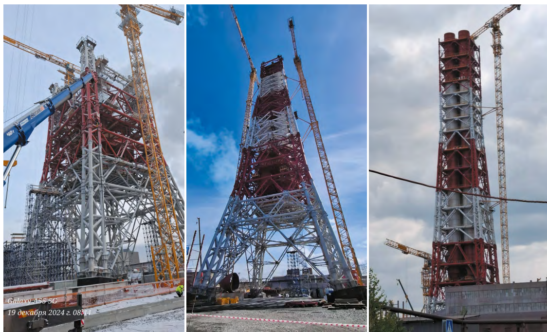
а (a) б (b) в (c) Рис. 2. Монтируемые (а – 19.12.2024; б – 24.04.2025) и окончательно установленные (в – 29.05.2025) конструкции башни, поддерживающие газоочистку аглофабрики
