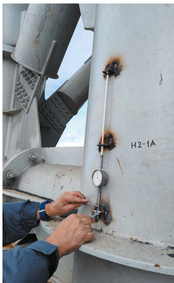
Рис. 7. Настройка механического тензометра перед измерением на конструкциях башни
