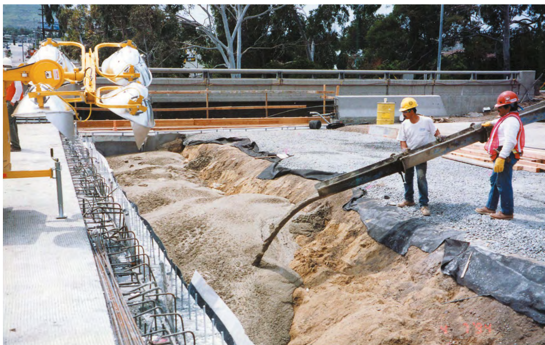
Рис. 4. Применение жидкого грунта в качестве обратной засыпки траншеи при укладке подземных труб Fig. 4. Controlled low strength material for backfilling trenches of underground pipes
