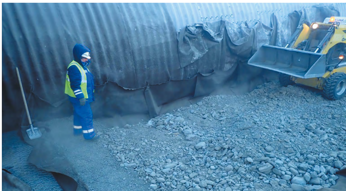
Рис. 2. Гофрированная труба \varnothing 4,5 м до засыпки Fig. 2. Corrugated pipe \varnothing 4.5 m before backfilling
