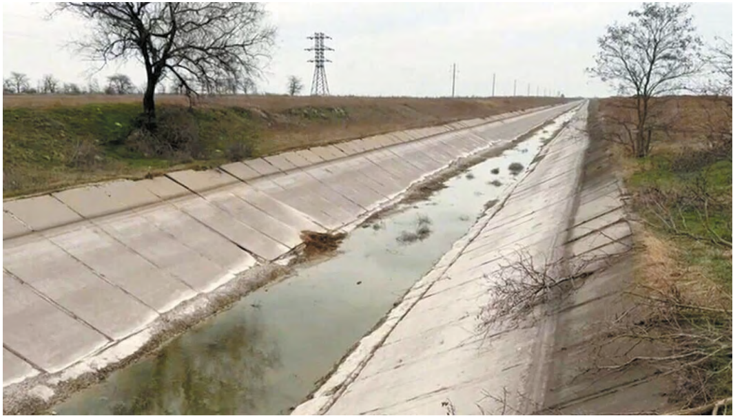
Рис. 3. Пример «поперечного» расположения облицовочных плит в русле канала (Северо-Крымский канал) [источник: https://cdn-st4.rtr-vesti.ru/vh/pictures/hd/407/988/3.jpg ]
