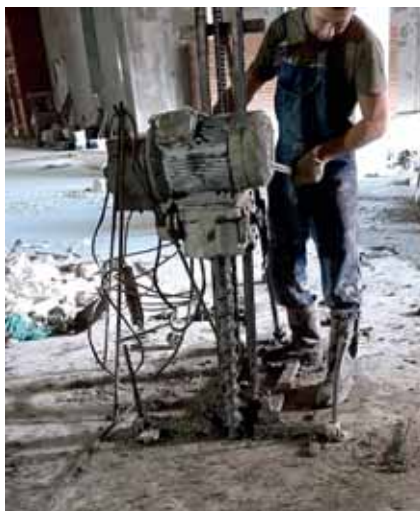
Рис. 8. Бурение в грунте скважины \varnothing 90 мм полым шнеком Fig. 8. Drilling of the 90 mm in diameter borehole with a hollow auger
