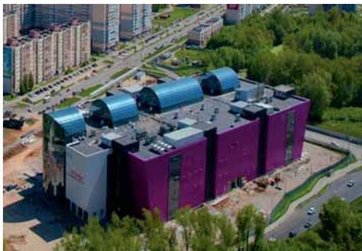
Рис.1. Общий вид торгово-развлекательного комплекса в г. Самаре Figure. 1 General view of the shopping Mall in the city of Samara
