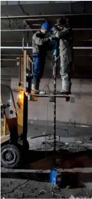
Рис. 10. Забивка иньектора Fig. 10. Injector driving
